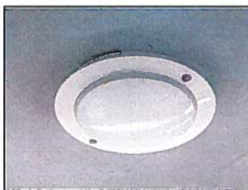
ภาพที่ 32 Heat Detector
