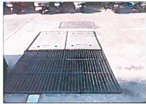
ภาพที่ 34 ตะแกรงดักขยะที่ Man Hole
